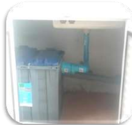
ชุดถังดักไขมัน เพื่อบำบัดน้ำเสียขั้นต้น
