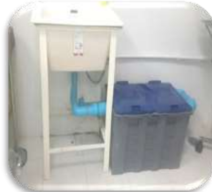
ชุดถังดักไขมัน เพื่อบำบัดน้ำเสียขั้นต้น
