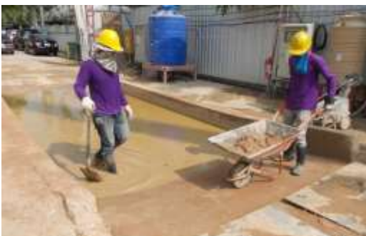
ขุดลอกบ่อล้างล้อรถ
