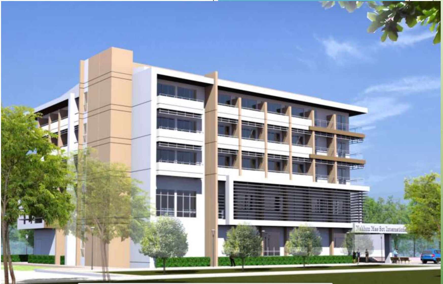
ภาพรวมโครงการเมื่อก่อสร้างแล้วเสร็จ
